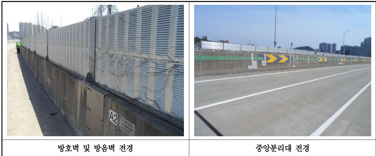
【사진 11.3.24】 방호벽 및 중분대 전경
