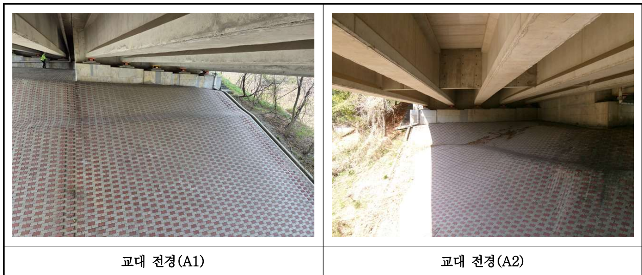
【사진 11.3.8】 교대 전경
