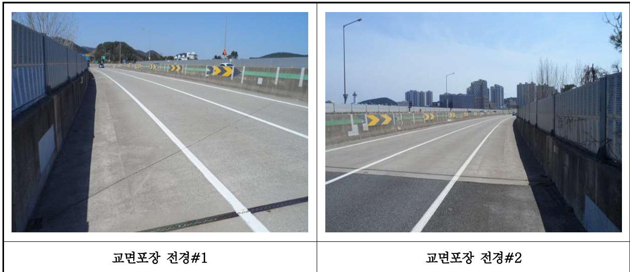
【사진 11.3.20】 교면포장 전경
