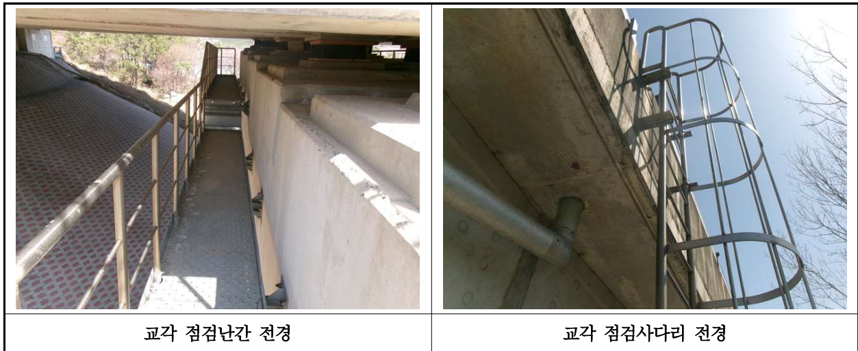
【사진 11.3.26】 교량 점검시설 전경
