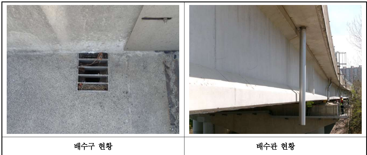
【사진 11.3.22】 배수시설 전경
