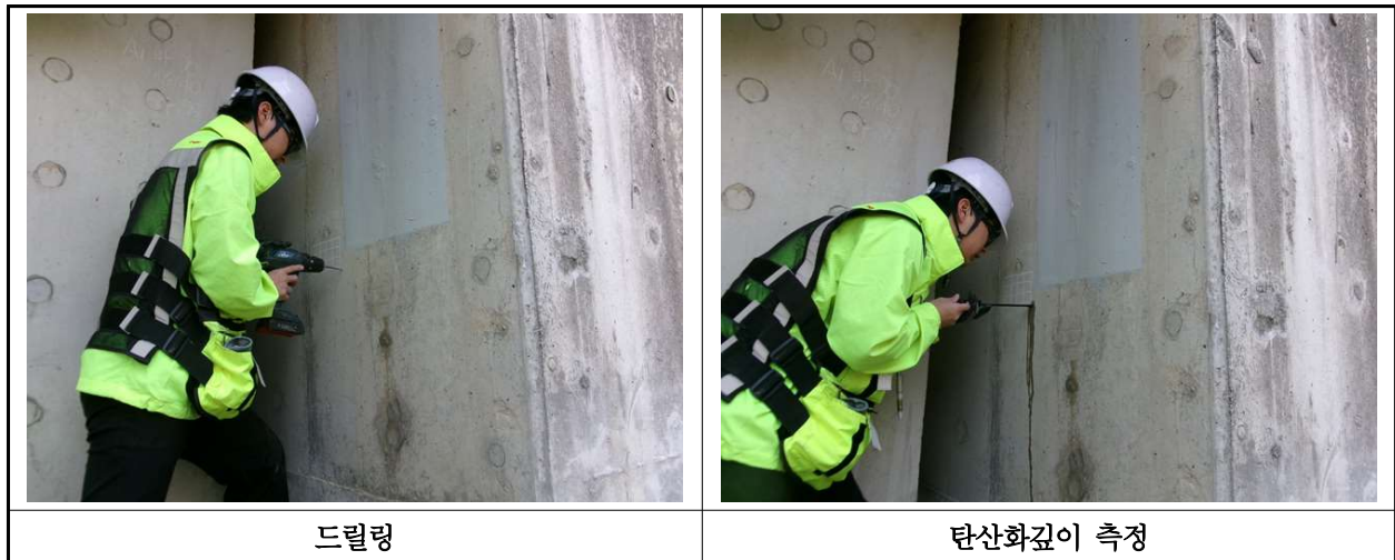
【사진 11.4.3】 탄산화 깊이 측정 현장사진
