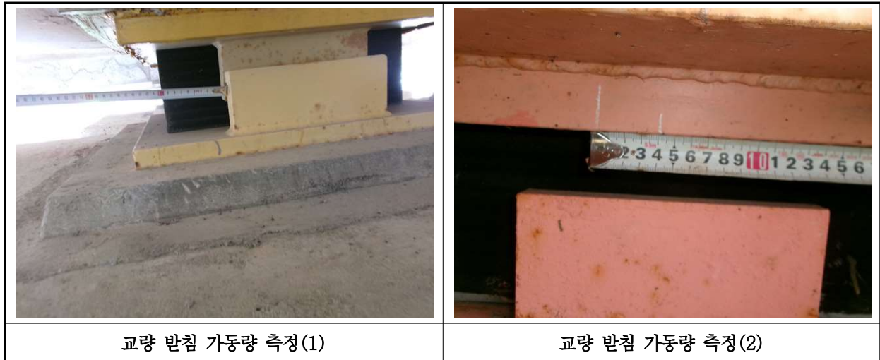
【사진 11.3.16】 교량받침 이동량 측정
