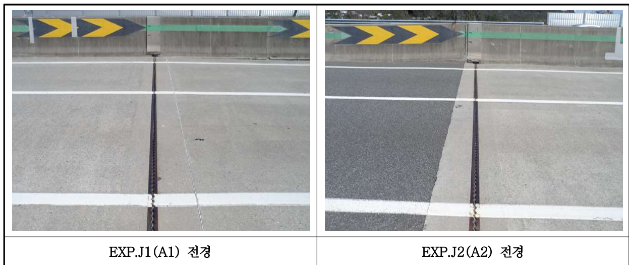
【사진 11.3.17】 신축이음장치 전경
