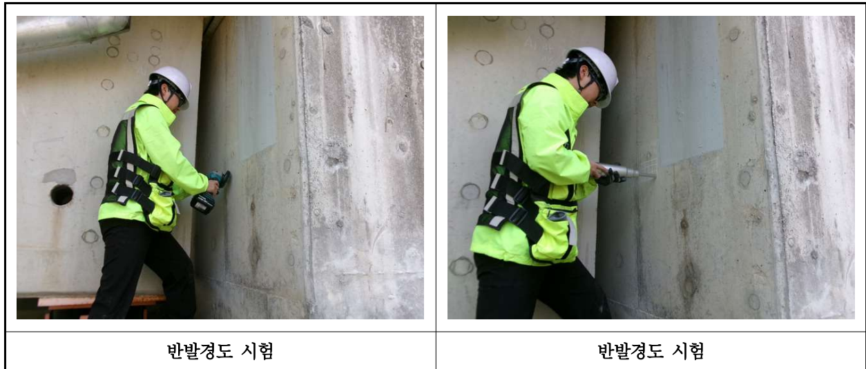
【사진 11.4.2】 반발경도시험 현장사진
