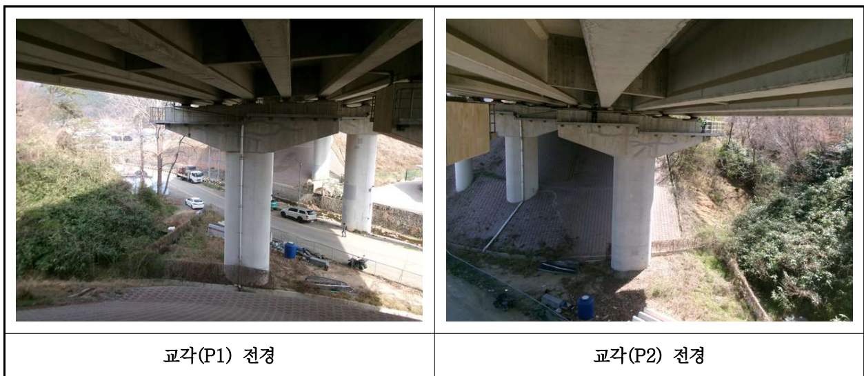
【사진 11.3.10】 교각 전경
