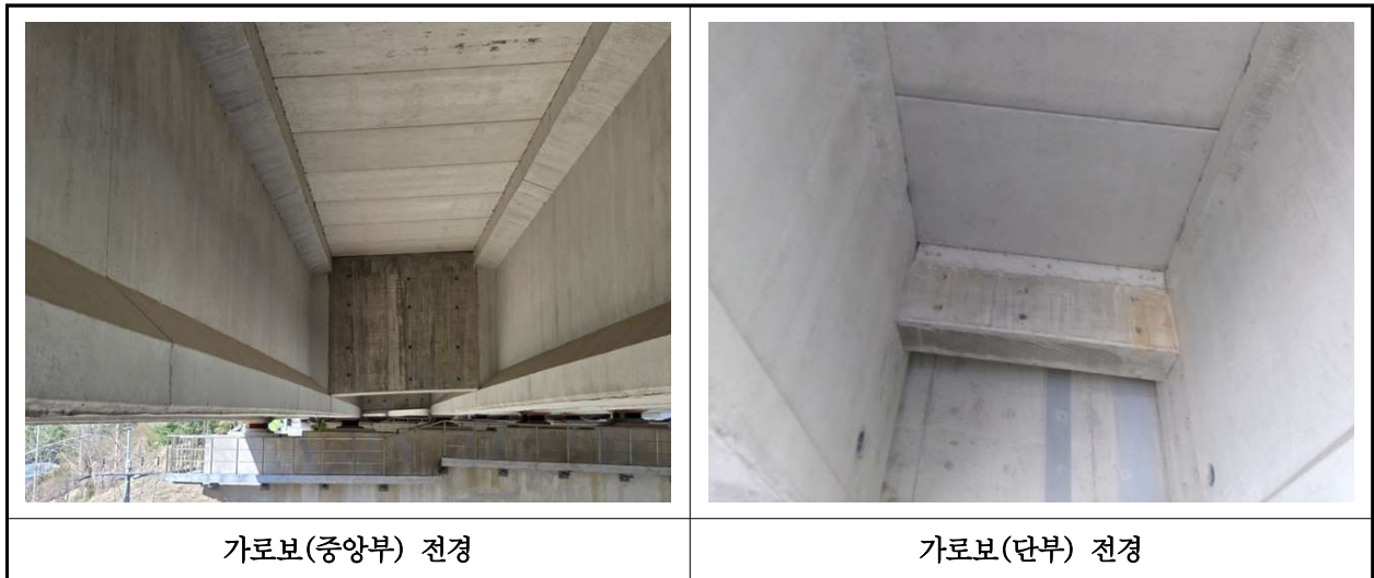
【사진 11.3.6】 가로보 전경
