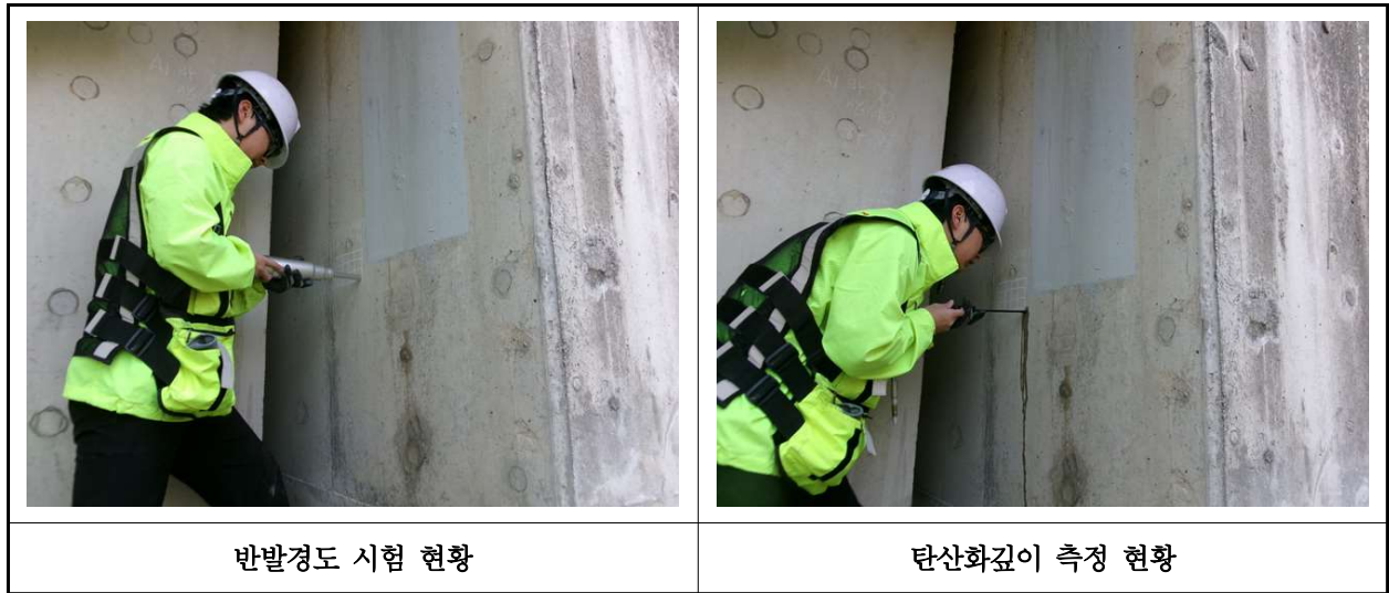
【사진 11.4.1】 콘크리트 내구성조사 현황
