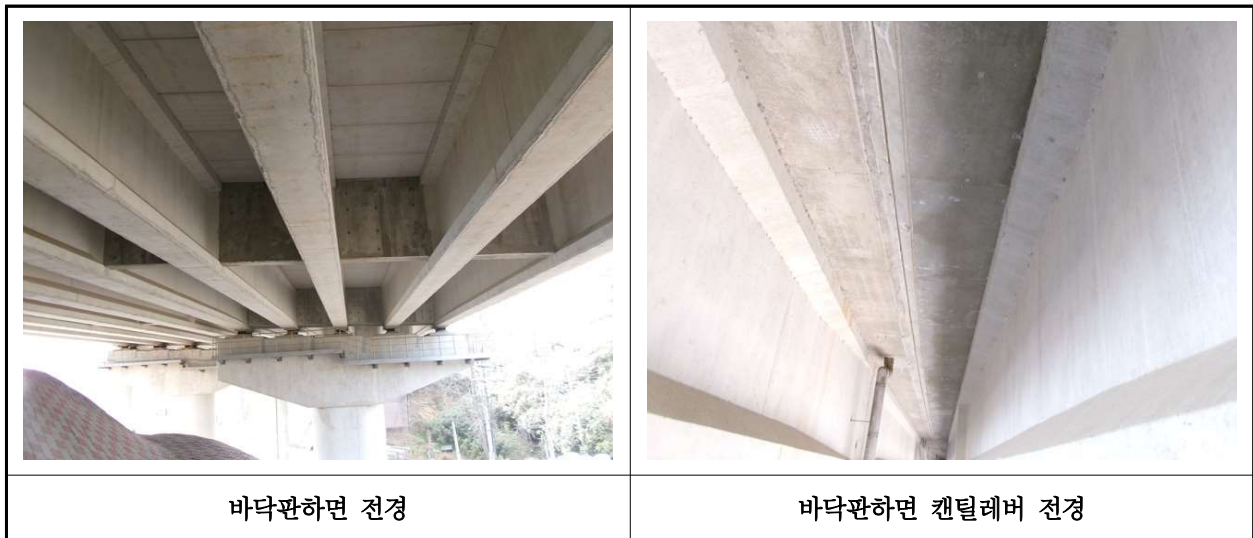
【사진 11.3.2】 바닥판하면 전경
