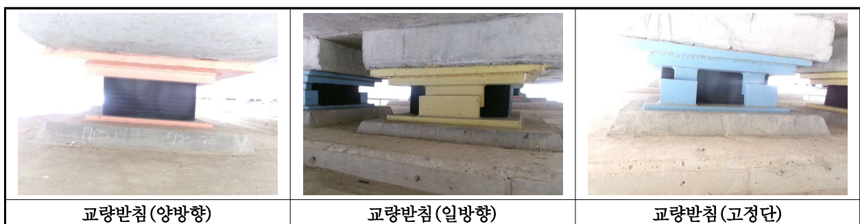
【사진 11.3.13】 교량반침 전경
